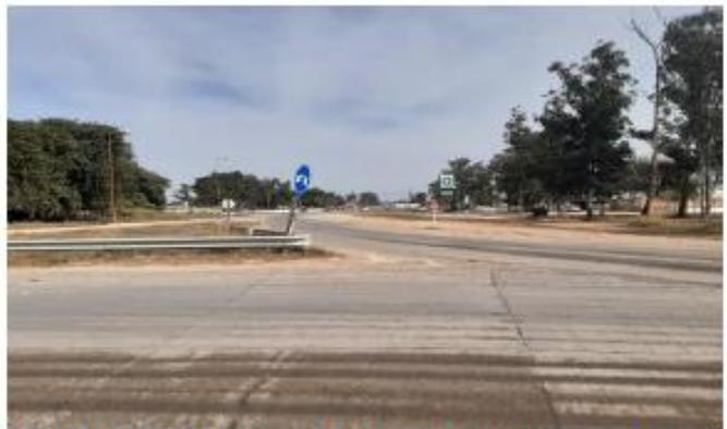
Señales inclinadas y exceso de barreras semirrígidas con peligrosas terminales "cola de pescado"
